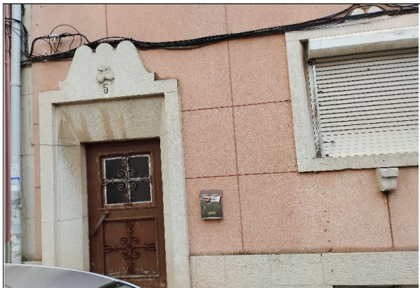
Entrada no edifício
